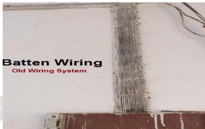
(Fig.5.3. Batten Wiring)
